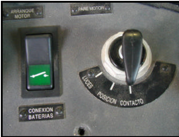
Foto B. Llave de contacto, desconexión baterías. IVECO
